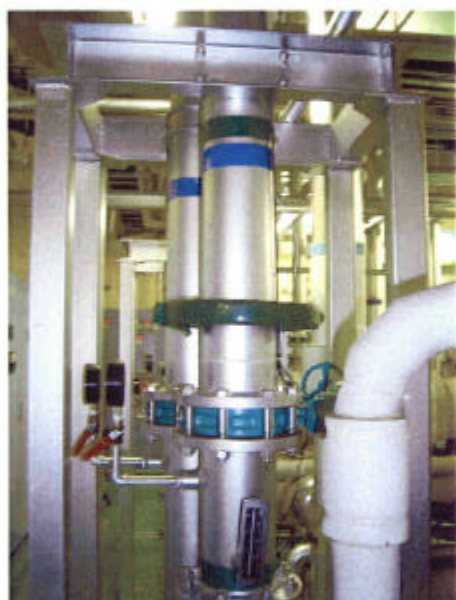
冷却水(還)管アリオレスL型装着
