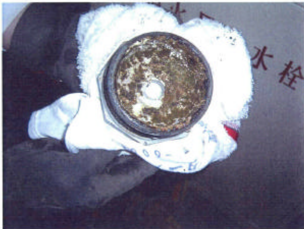
内視鏡挿入箇所配管蓋裏
