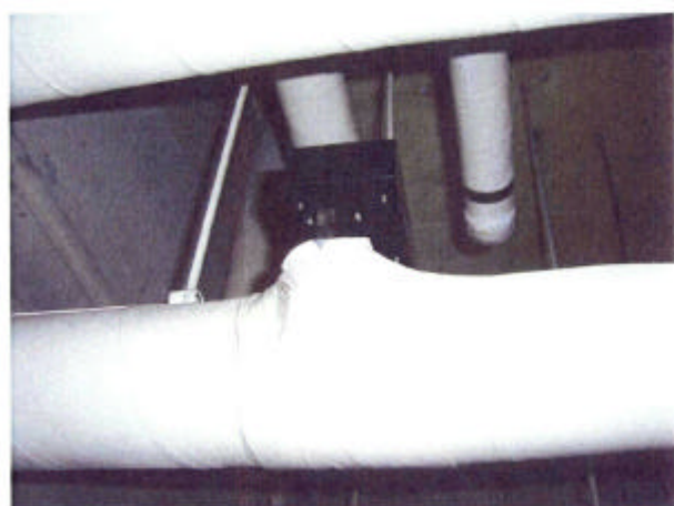
給湯配管アリオレスA型装着
