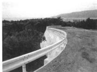
写真-4 完成した状況
