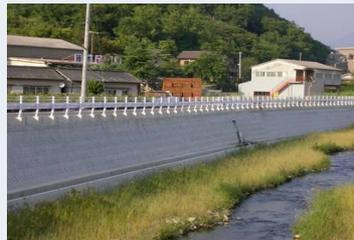
写真-2 ブロック積擁壁の上に設置状況
