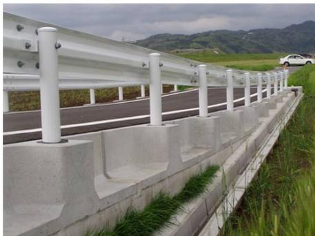
写真-4 L型擁壁への設置
