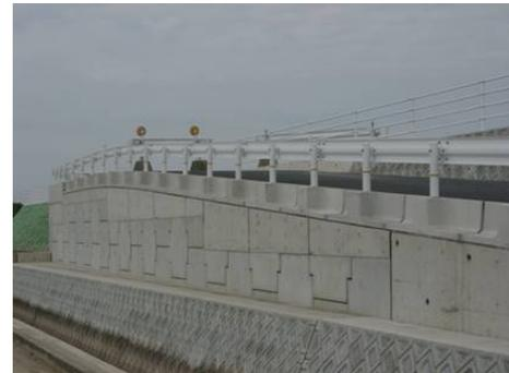
写真-5 補強土壁への設置
