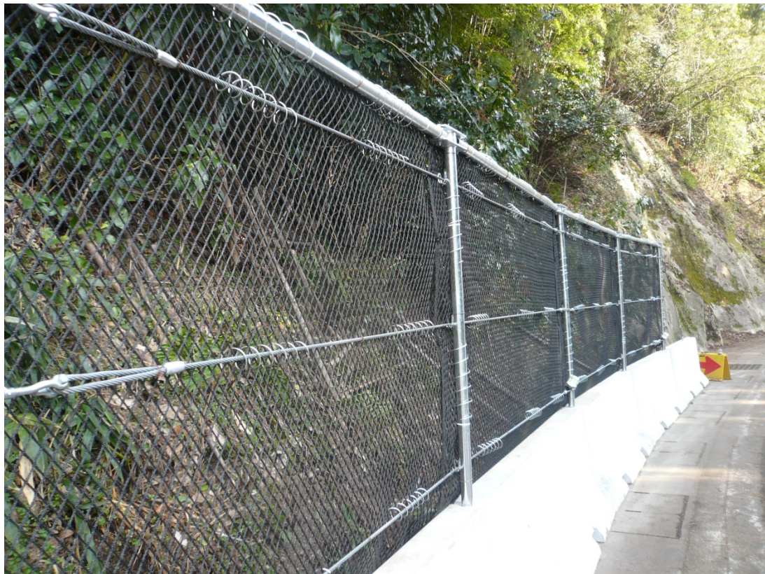
防護柵の近景
