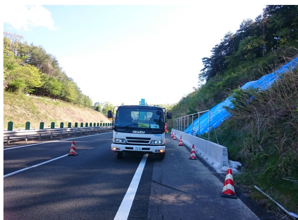
基礎擁壁・支柱・トッパー・横ロープ等の設置完了
