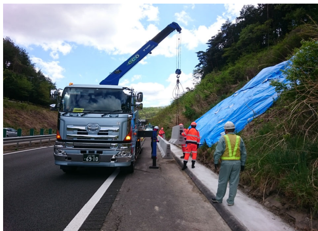
基礎擁壁の荷卸し状況
