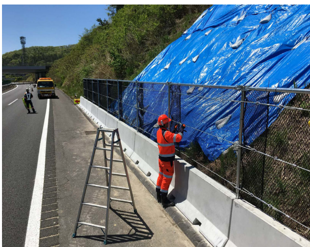
ネットの設置状況（1）
