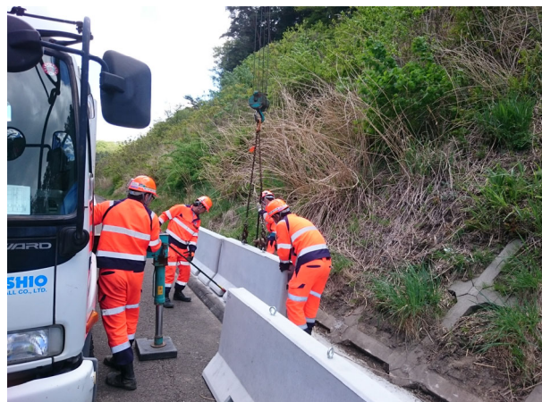
基礎擁壁の設置
