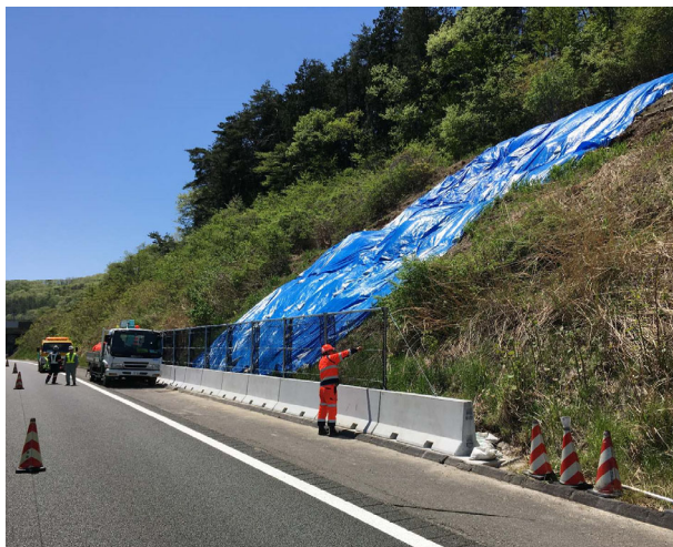
ネットの設置状況状況（2）
