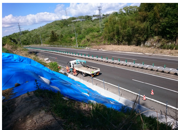
防護柵部の設置状況
